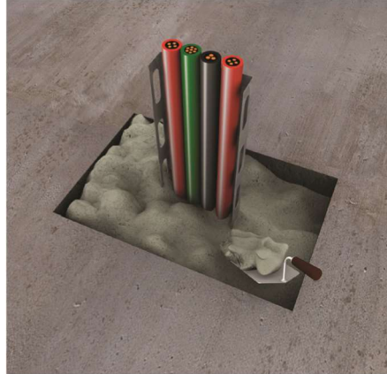
5. Önceden hazırlanmış olan kalıp üzerine en az 10 cm kalınlıkta PROMASTOP®-M yerleştirilir. Duvar geçişlerinde ise, tek taraftan kalıp desteği yeterli olup, uygulamanın ertesi gününde kalıp desteği alınabilir.
